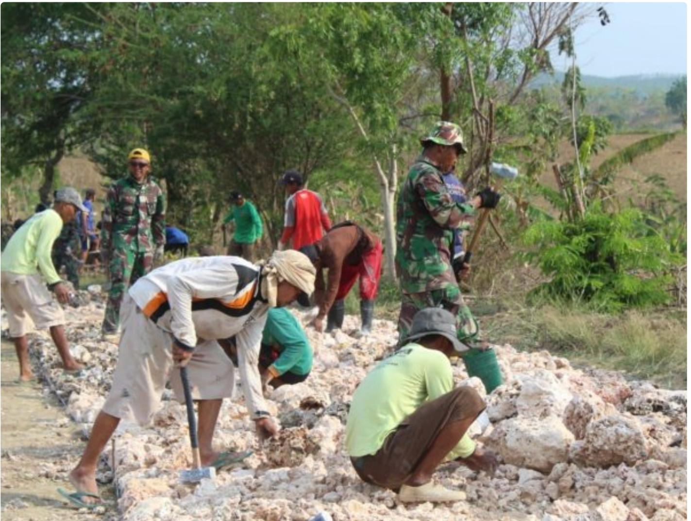
*Foto: Pembuatan jalan makadam yang menghubungkan desa Jatiroyom dan Parunggalih, sepanjang 1.700 meter dan lebar 3 meter, terus dipercepat oleh Satuan Tugas (Satgas) TMMMD reguler 122 Kodim 0721/Blora. Minggu, 20 Oktober 2024.*
